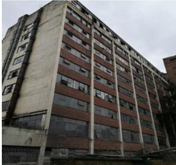
Figura 3. Vista Interna del Costado Suroccidental del Bloque Central
