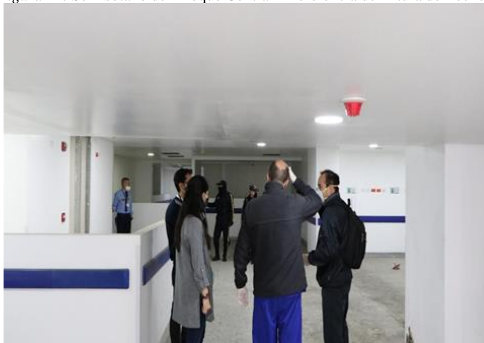
Figura 11. Semisótano del Bloque Central - Referencia de Altura de Techos
